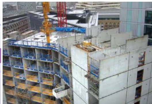
Ilustración 4 – Ejemplo de edificio con muro portante
